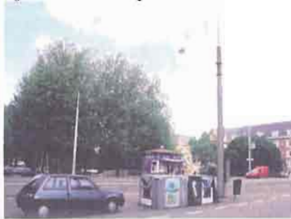
Figuur 23: Bovenleiding tram 5
